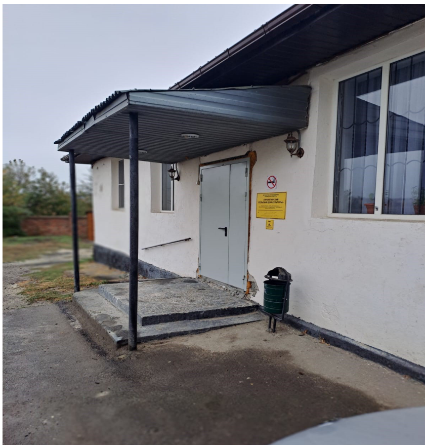
Фото №4 Входная площадка (перед дверью)
