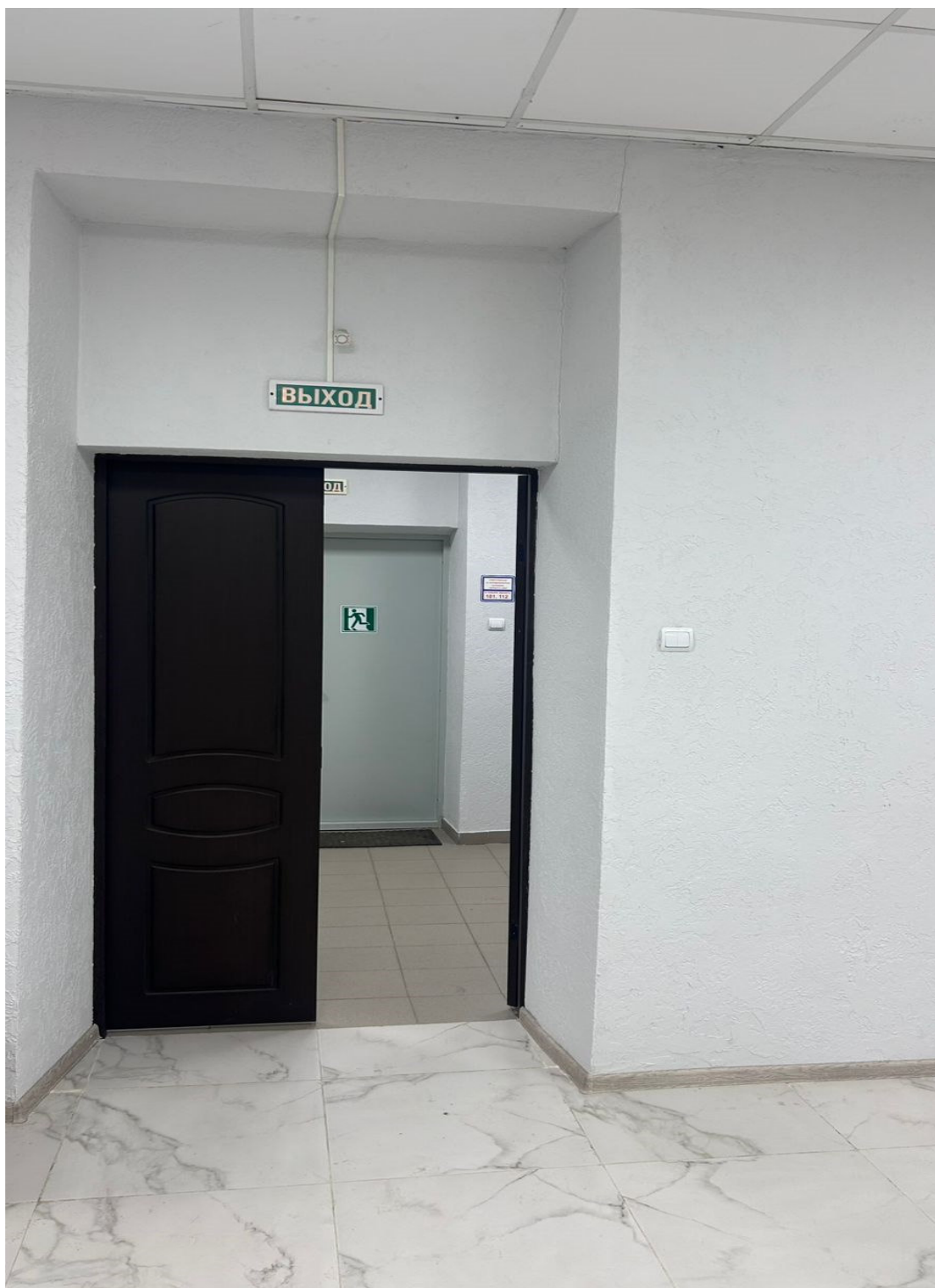
Фото №8 Пути эвакуации (в т.ч. зоны безопасности)
