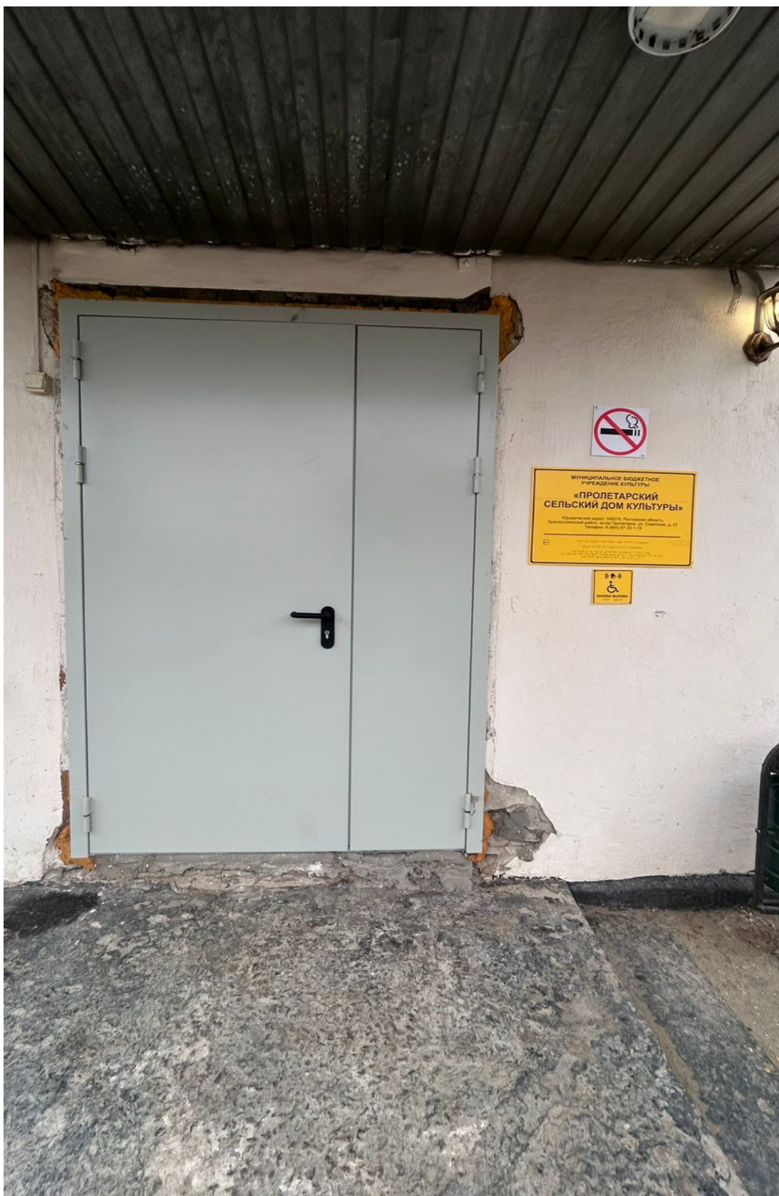
Фото №5 Дверь (входная)
