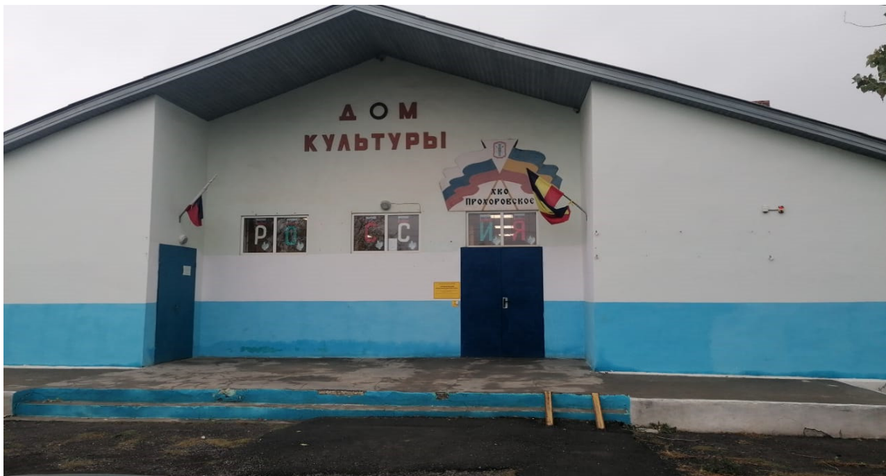
Фото №4 Дверь (входная)
